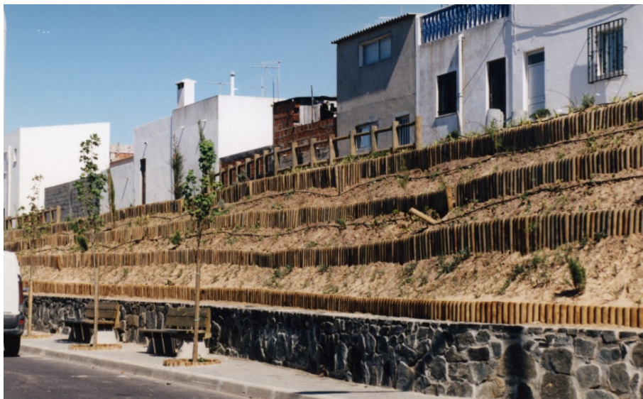
FIG 4: VISTA DA RUA JOÃO DOROTEIA APÓS ARRANJOS EXTERIORES 2002. Arquivo Municipal de Sines, Coleção Fotográfica, CF0258.082.
