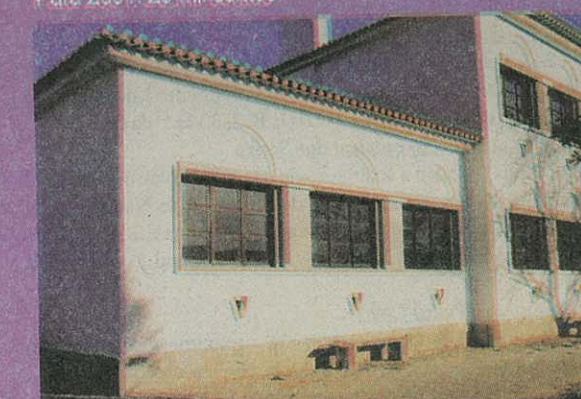
EB n.º 1 de Sines (edifício novo + melhorias, etc.) Total: cerca de 155 mil contos Para 2001: cerca de 113 mil contos
