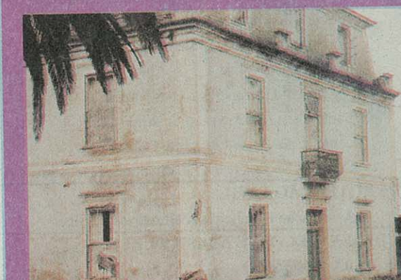
Edifício Pidwell (início da recuperação para a instalação da delegação do Conservatório de Música do Baixo Alentejo) Total: 100 mil contos Para 2001: 50 mil contos
