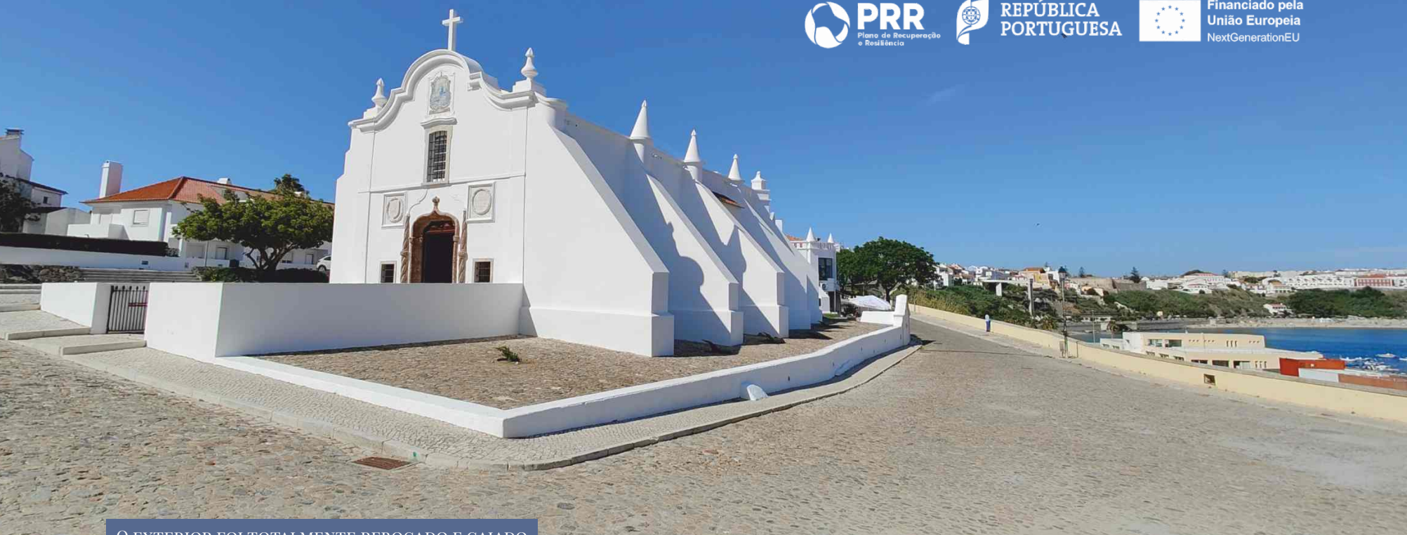
O EXTERIOR FOI TOTALMENTE REBOCADO E CAIADO
