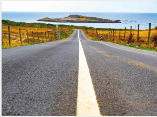
Concluiu a repavimentação da Estrada da ilha do Pessegueiro - CM 1115-1 (235 675 €)
