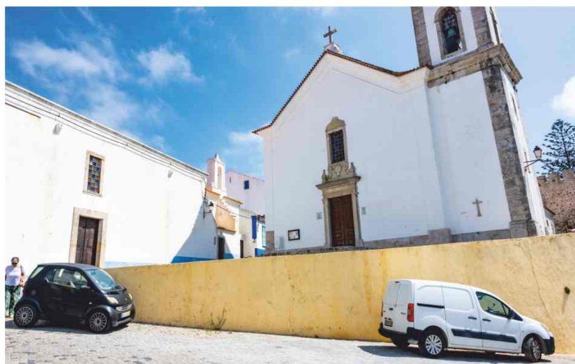
Remoção de RSU enterrados na Rua do Muro da Praia e Av. Vasco da Gama (concluída)
