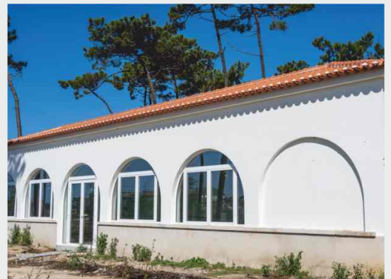
Concluiu os trabalhos de arquitetura da operação "Requalificação do Lavadouro do Parque de Merendas de Sines" (operação FEADER: 149 643,41 €)
