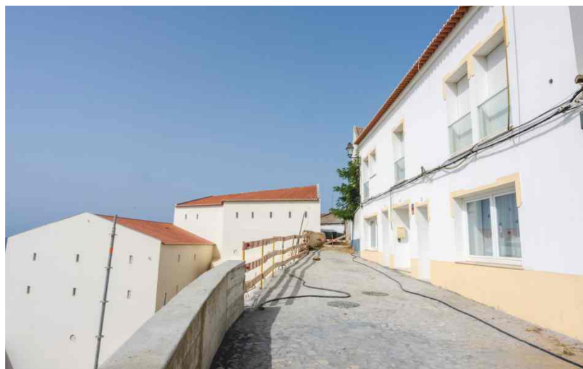
Empreitada na Rua do Forte (a decorrer)
