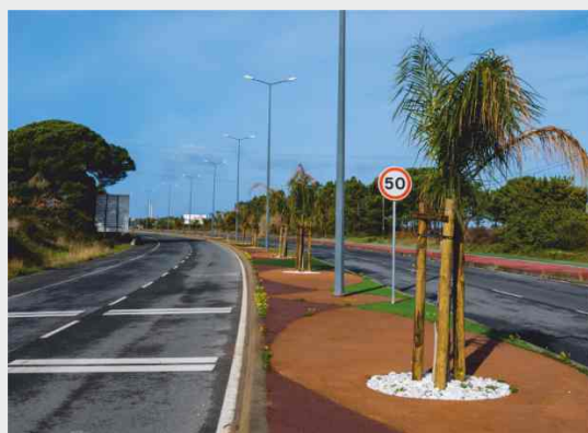
Executou o separador central entre as rotundas na via rápida à entrada de Sines (124 417 €)
