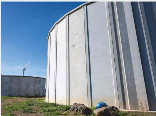
Construiu um novo reservatório de água do Monte Chãos com 500 m³ de capacidade (450 693 €) e instalou um reservatório pré-fabricado de 300 m³ em Porto Covo (47 681 €)
