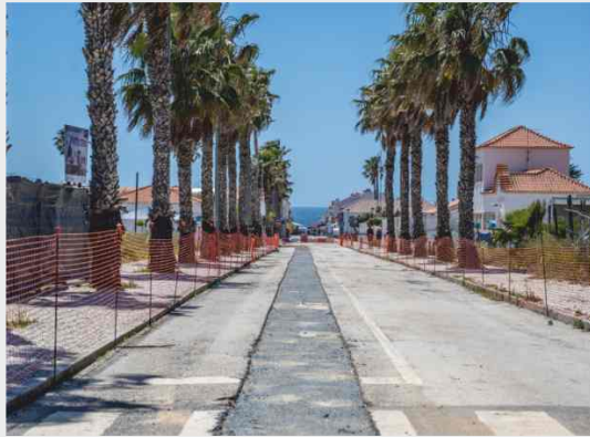
Concluiu a empreitada de "Requalificação da adutora Bica de Cima - Porto Covo" (281 463 €)
