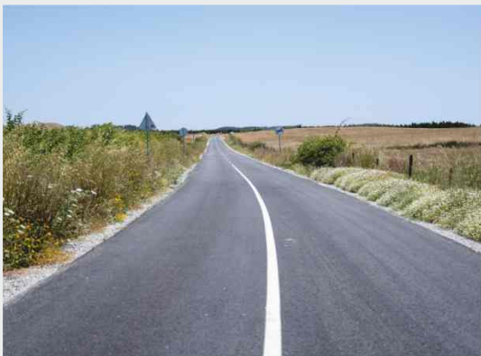
Executou a empreitada de Repavimentação da Estrada da Cabeça da Cabra - CM 1116 (536 843 €)
