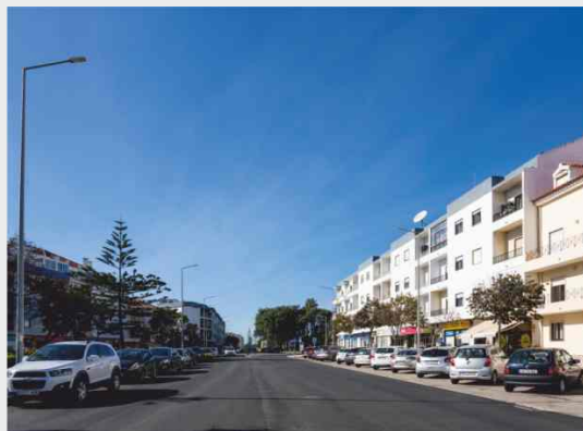
Concluiu uma empreitada de reparação de betuminosos no concelho de Sines , realizada entre 2021 e 2023 (784 932 €)
