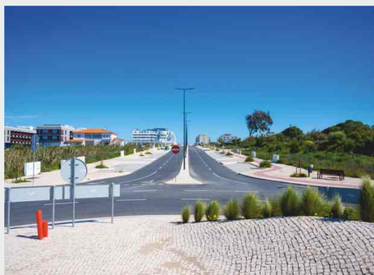
Executou pavimentos e infraestruturas ao longo da avenida principal do Loteamento Municipal Sul-Nascente - Estrada do Encalhe (1 848 057 €)
