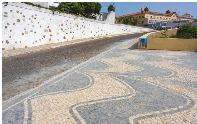
Trabalhos em calçada na Rua de N.ª Sr.ª das Salvas (executados pelos serviços municipais)
