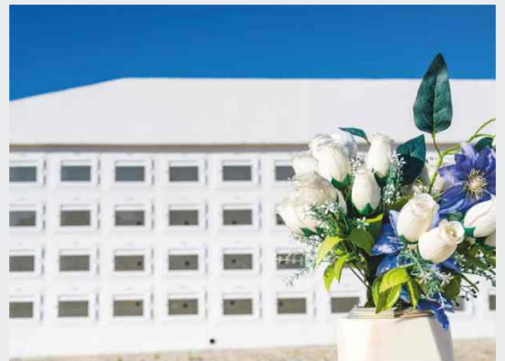
Construiu 432 novos ossários no Cemitério de Sines (162 496 €)
