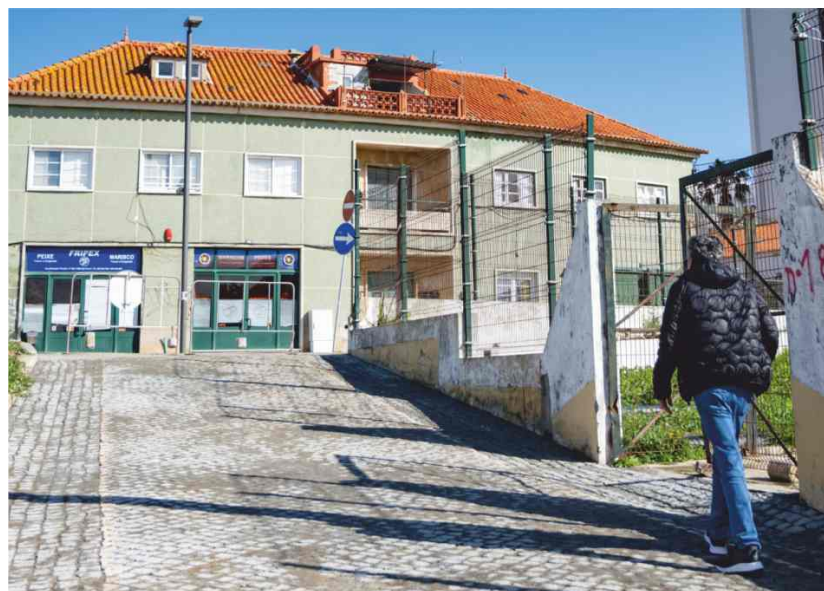
Repavimentação da Travessa Vasco da Gama
