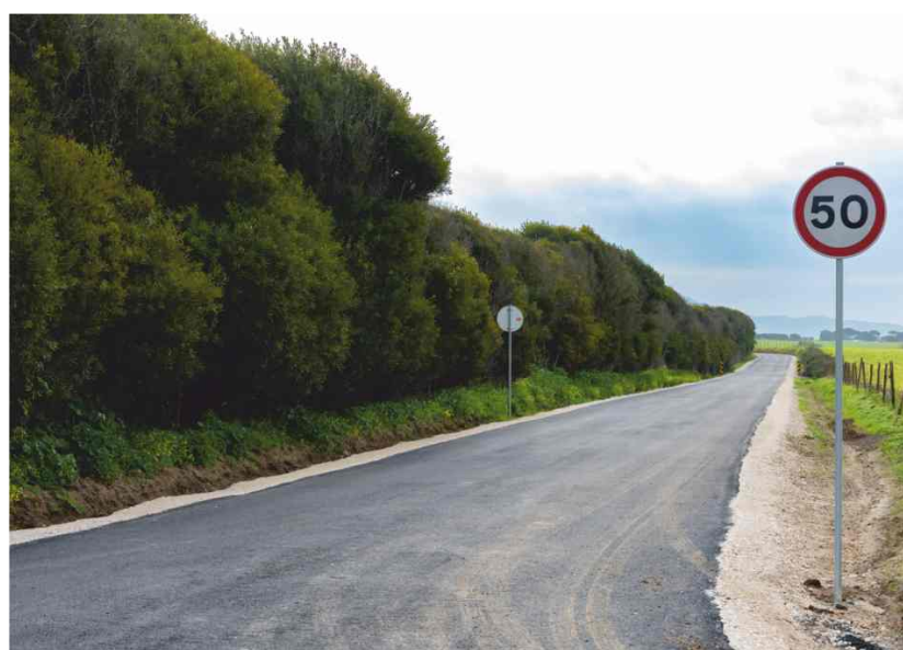
Repavimentação da Estrada da Cabeça da Cabra
