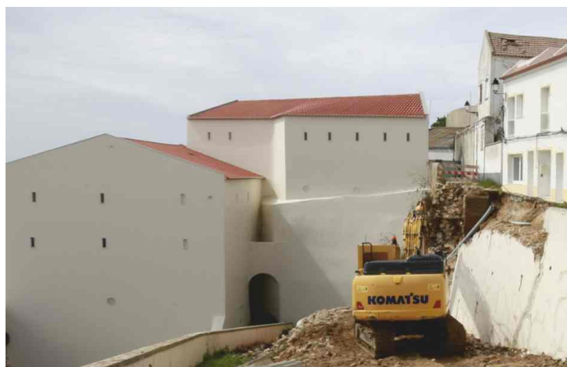
Intervenção na Rua do Forte
