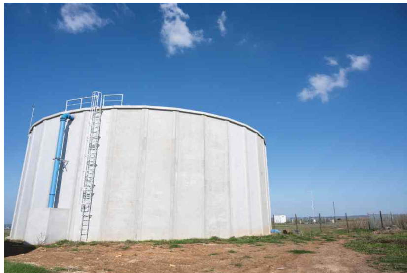
Novo reservatório de 5000 m 3 no Monte Chãos
