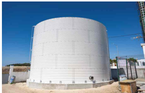
Reservatório de 300 m 3 em Porto Covo - aguarda ligação à rede
