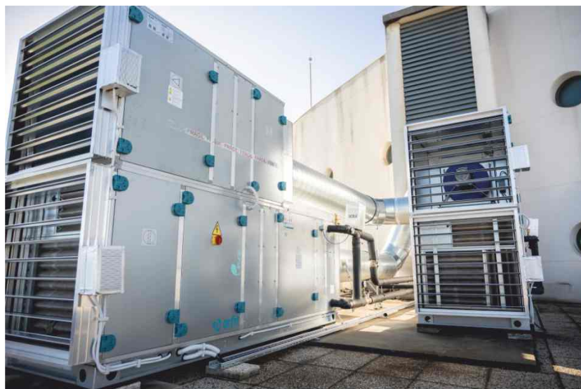
Substituição da unidade de tratamento do ar da Piscina Municipal
