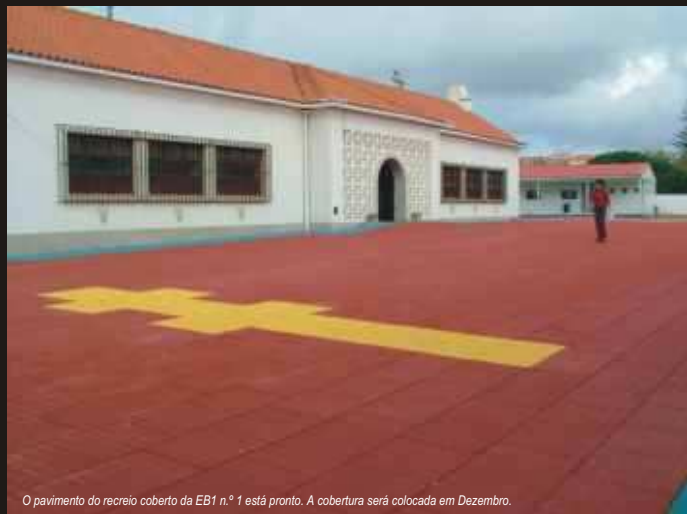
O pavimento do recreio coberto da EB1 n.º 1 está pronto. A cobertura será colocada em Dezembro.
