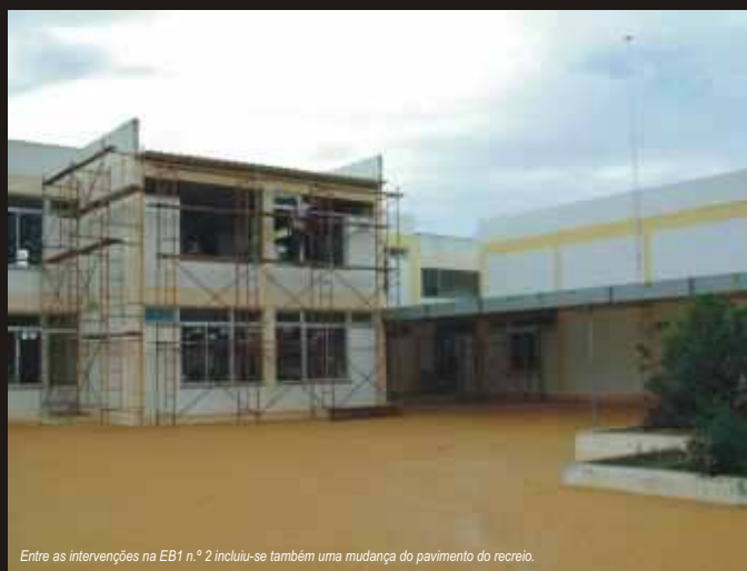
Entre as intervenções na EB1 n.º 2 incluiu-se também uma mudança do pavimento do recreio.
