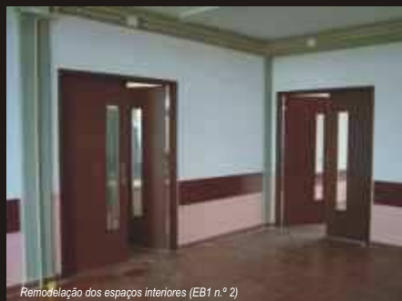
Remodelação dos espaços interiores (EB1 n.º 2)
